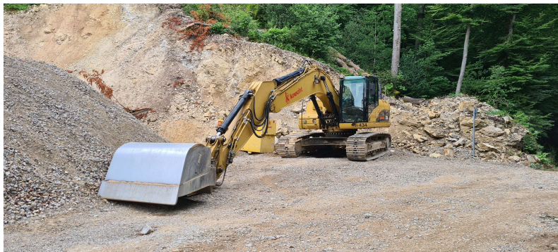
Der Bagger steht für den Mergelaufladung bereit
