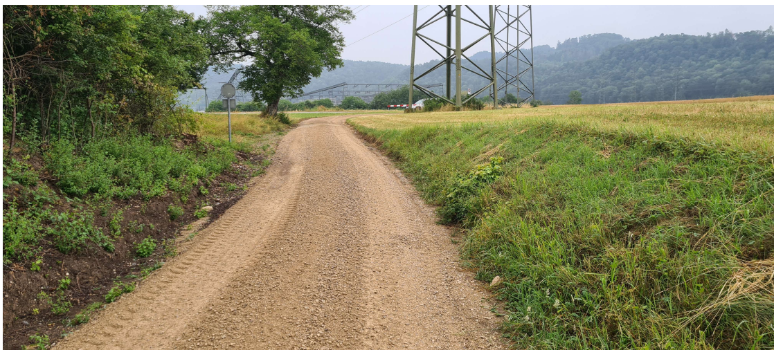
frisch Überführte Strasse
