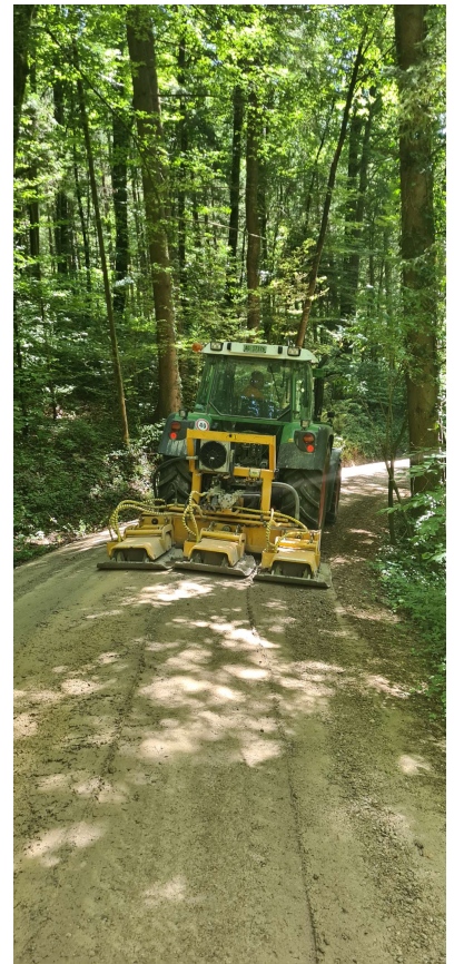
Traktor mit Plattenverdichter beim einvibrieren der neuen Ver- schleisssschicht
